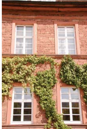
Hausteinfassade heim. Rotsandstein
