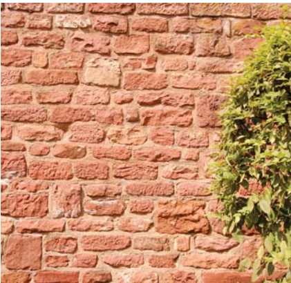
unregelmäßiges Sandsteinmauerwerk
